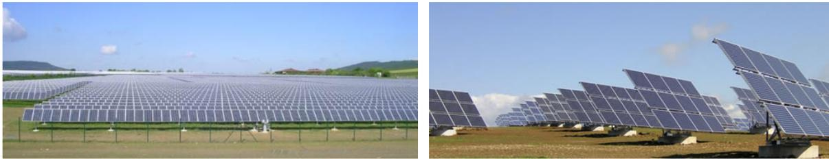
**Abbildung 15: Beispiele für die Aufständering von PV-Modulen**
