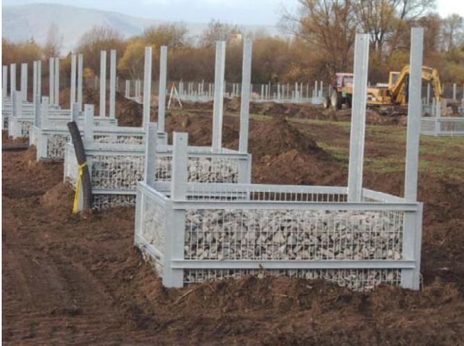
Abbildung 50: Beispiel für ein Gabionenfundament (Steine in Stahlkorb)
