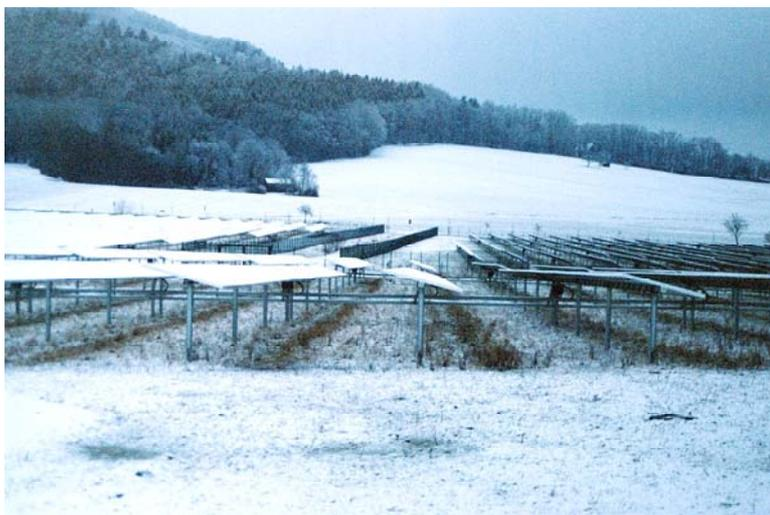
**Abbildung 23: Schneefreie Bereiche unter Modulen in Mühlhausen**
