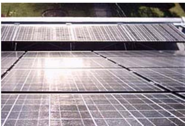
**Abbildung 10: Beispiel für Lichtreflexion an Moduloberflächen**
