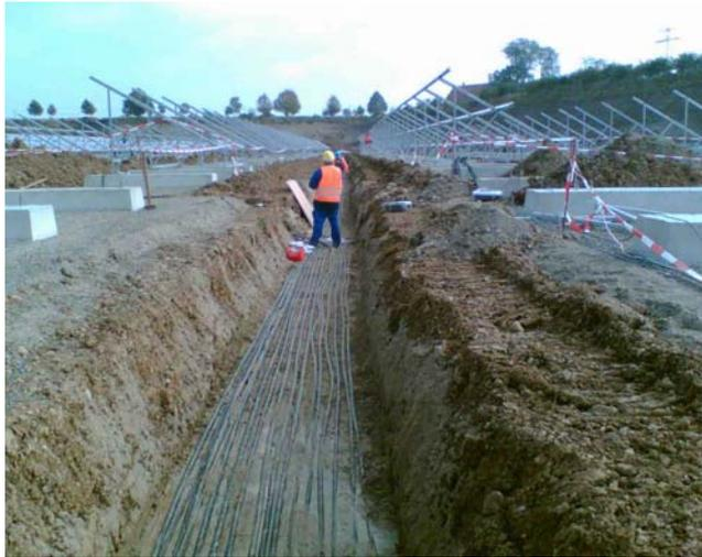
**Abbildung 6: Beispiel für die Verlegung der Erdkabel im Kabelgraben**
