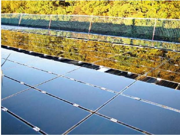
**Abbildung 12: Spiegelung an Moduloberflächen**
