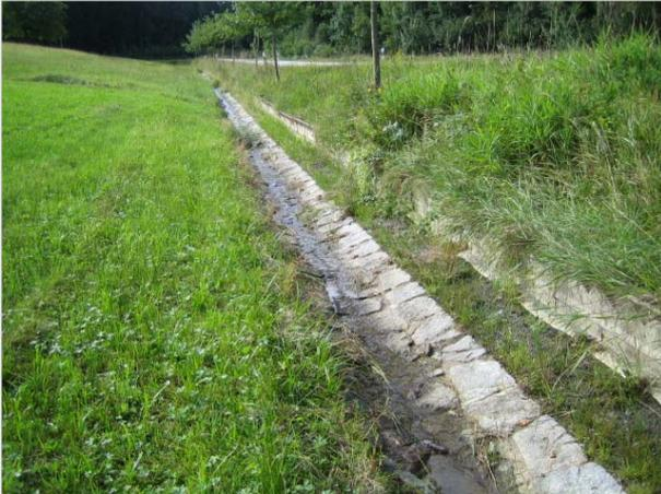
1 Verbauter Graben ohne Selbstreinigungsfunktion östl. Buchetwies → Entfernen des Verbaus
