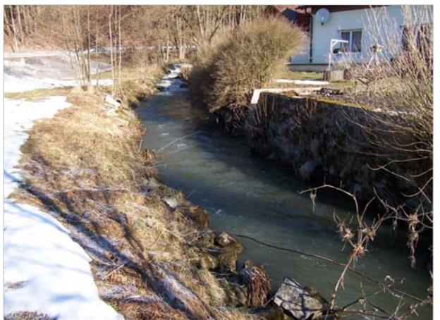
12 Verbauter Mettenbach bei km 2,5 → Schaffung von Retentionsräumen rechts, Laufverlängerung soweit möglich, Verbesserung des Ausuferungsvermögens
